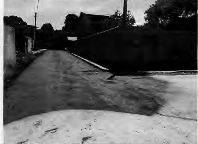
Imprimação de base Rua C - Antônio Batista
