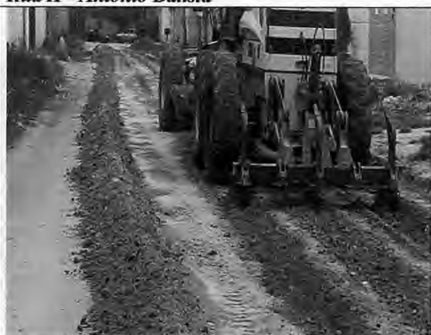
Abertura de caixa de rua Rua I - Antônio Batista
