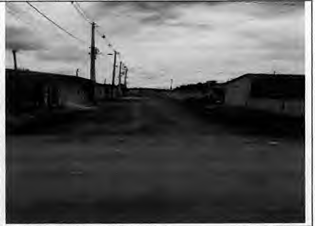
Asfaltamento Rua I - Antônio Batista
