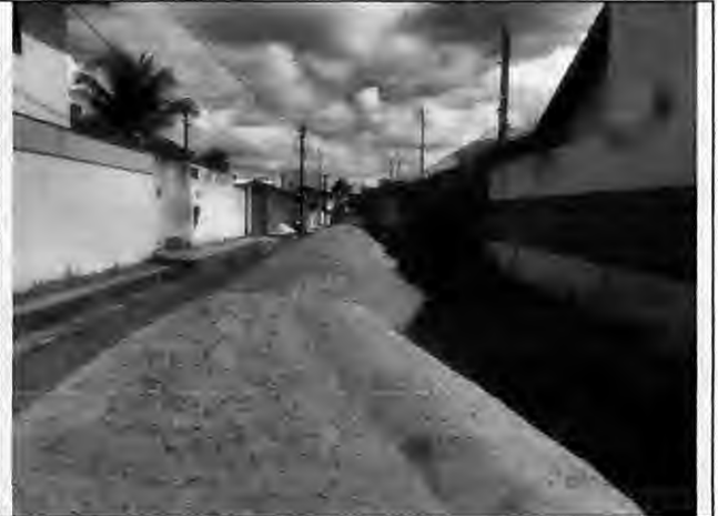
Lançamento de material de base Rua Projetada 03 - Pequi
