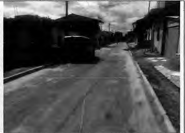
Execução de meio fio Rua E - Antônio Batista
