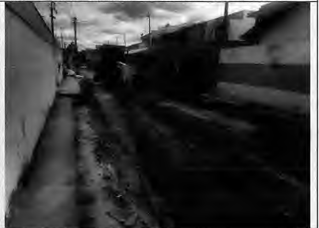
Abertura de caixa de rua Rua A – Antônio Batista
