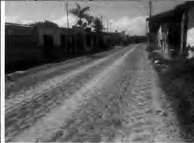
Execução de base Rua Projetada 03 - Pequi
