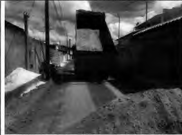
Lançamento de material de base Rua Projetada 03 - Pequi
