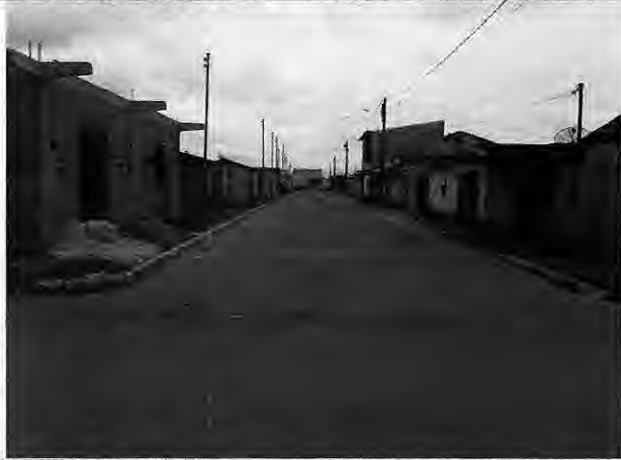
Asfaltamento Rua Sombra da Tarde – Antônio Batista
