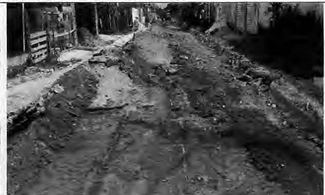
Abertura de caixa de rua Rua Sombra da Tarde – Antônio Batista
