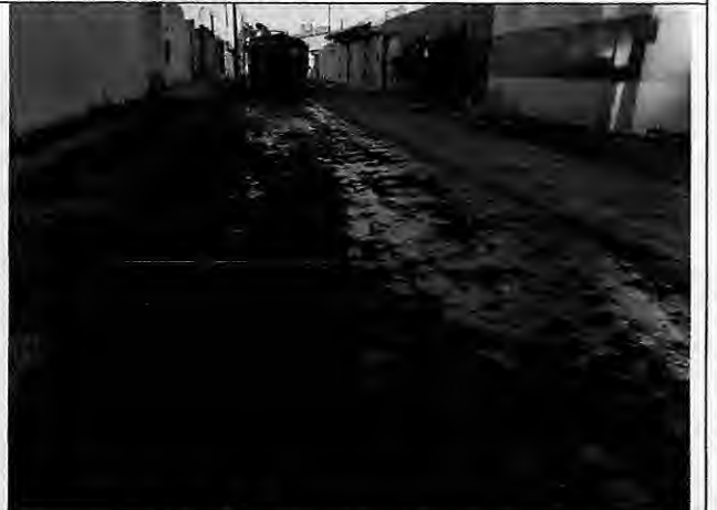
Imprimação de base Rua B - Antônio Batista
