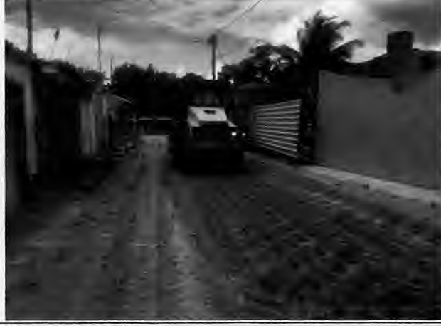
Execução de base Rua A – Antônio Batista
