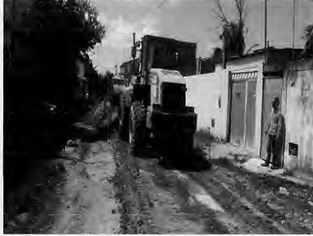
Regularização de Subleito Rua Jeruzalém – Antônio Batista
