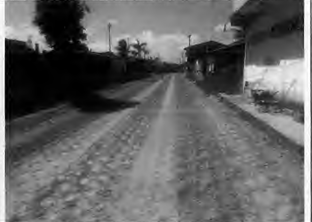
Execução de base Rua Israel – Antônio Batista
