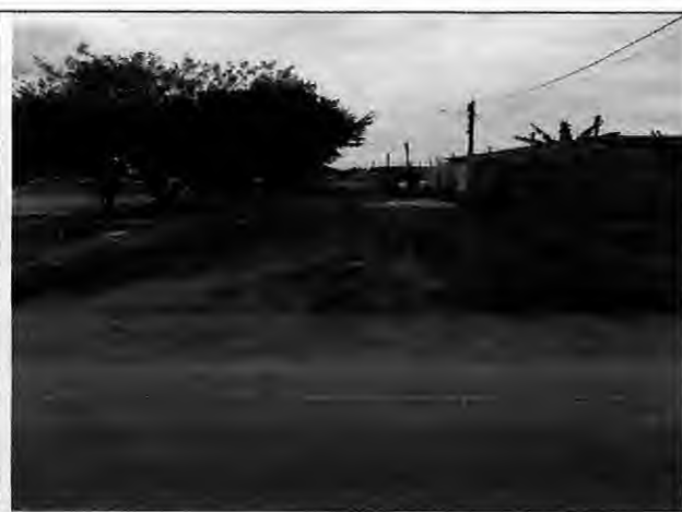
Asfaltamento Rua H - Antônio Batista
