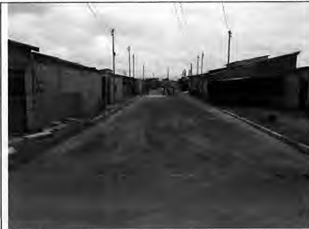
Asfaltamento Rua Jeruzalém – Antônio Batista
