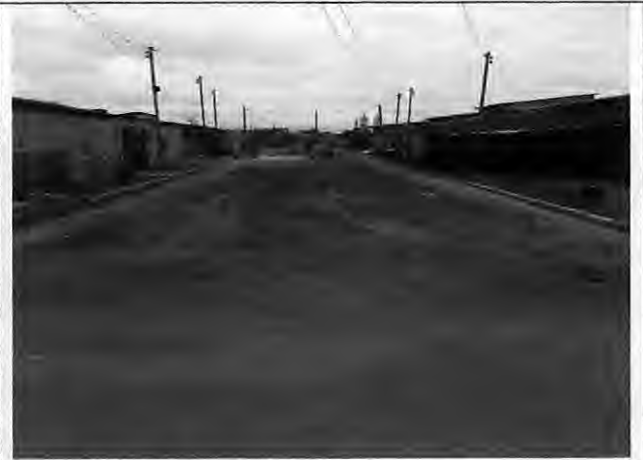
Asfaltamento Rua Jeruzalém – Antônio Batista
