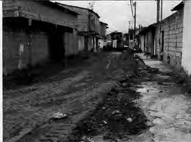
Lançamento de material de base Rua C - Antônio Batista
