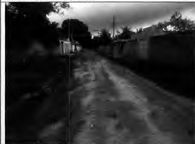
Regularização de Subleito Rua E - Antônio Batista
