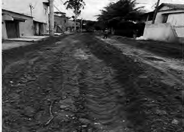
Lançamento de material de base Rua F - Antônio Batista
