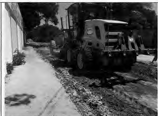
Abertura de caixa de rua Rua E - Antônio Batista
