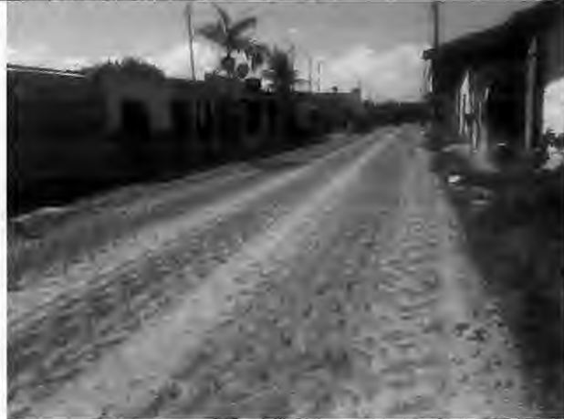
Execução de base Rua Israel – Antônio Batista
