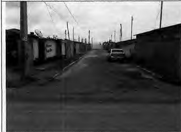
Execução de meio fio Rua Israel - Antônio Batista
