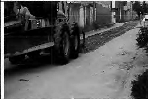
Abertura de caixa de rua Rua H - Antônio Batista
