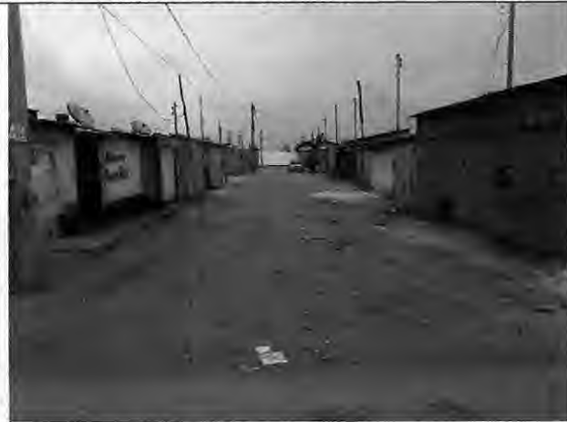
Abertura de caixa de rua Rua Israel – Antônio Batista
