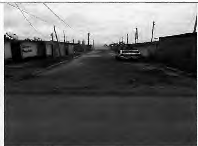
Asfaltamento Rua Israel – Antônio Batista
