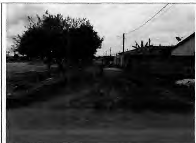
Asfaltamento Rua H - Antônio Batista
