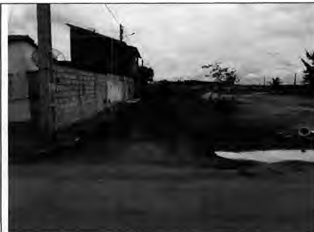
Asfaltamento Rua G - Antônio Batista
