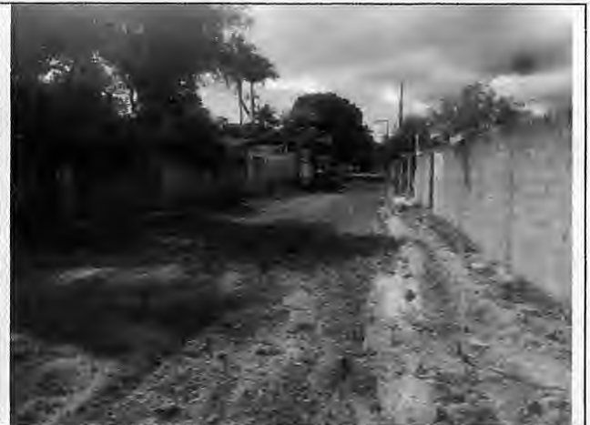
Execução de base Rua E - Antônio Batista
