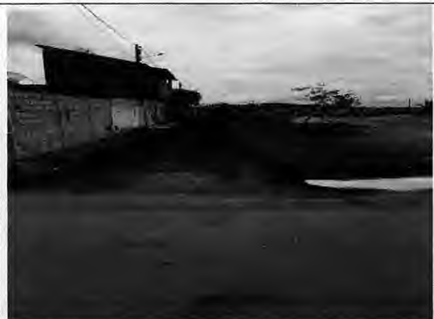
Asfaltamento Rua G - Antônio Batista
