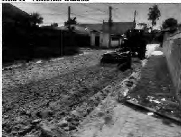
Execução de base Rua H - Antônio Batista
