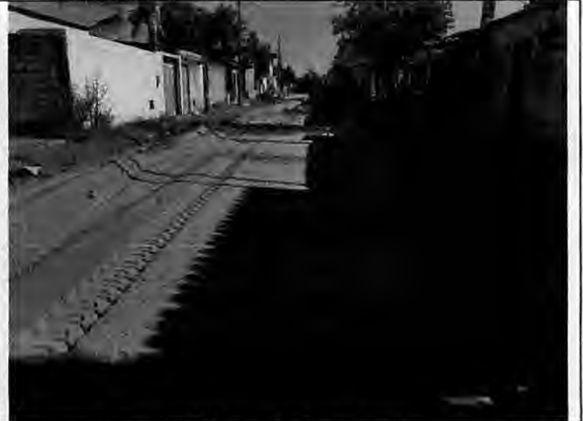
Lançamento de material de base Rua Israel – Antônio Batista
