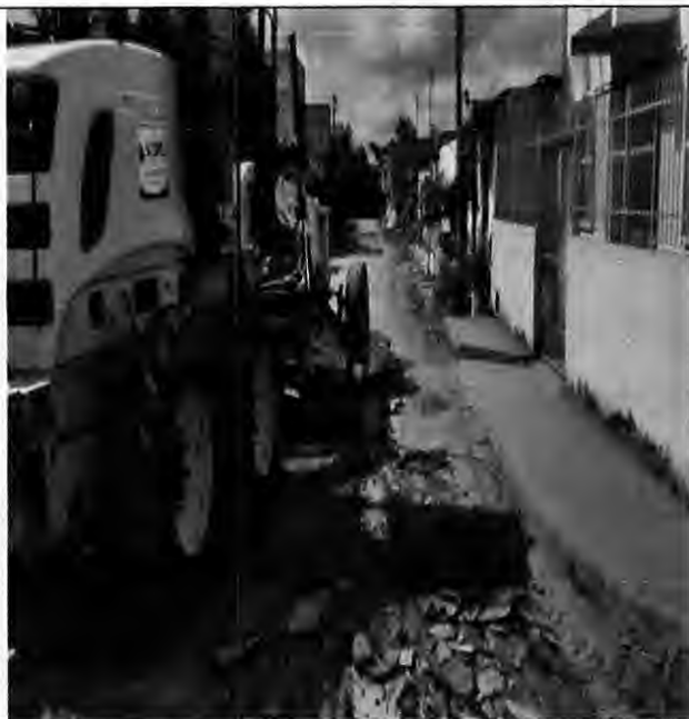
Abertura de caixa de rua Rua B - Antônio Batista
