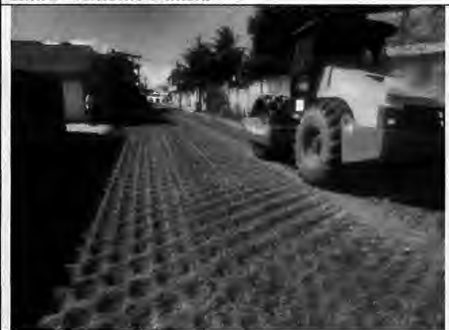
Execução de base Rua I - Antônio Batista
