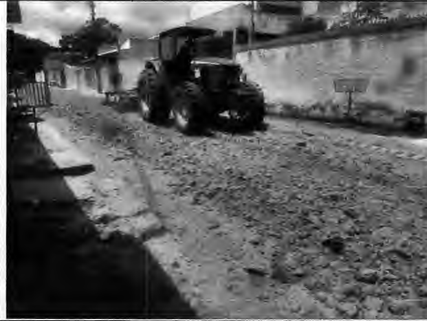
Execução de base Rua B - Antônio Batista
