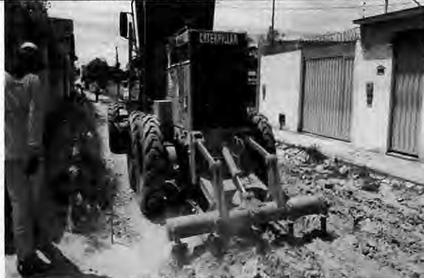
Abertura de caixa de rua Rua Projetada 03 - Pequi
