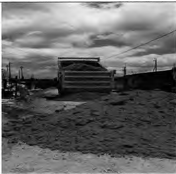
Lançamento de material de base Rua das Missões – Antônio Batista
