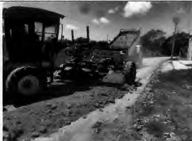
Lançamento de material de base Rua B - Antônio Batista
