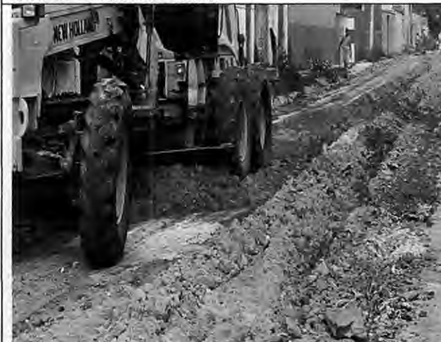
Regularização de Subleito Rua H - Antônio Batista
