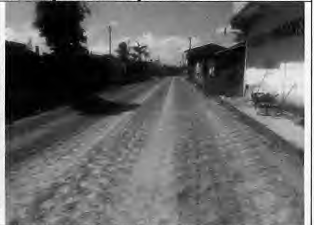
Execução de base Rua Projetada 03 - Pequi
