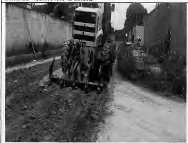
Abertura de caixa de rua Rua I - Antônio Batista
