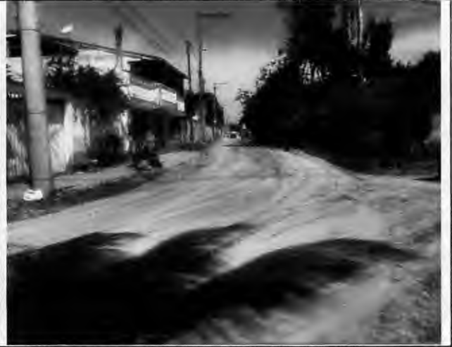
Lançamento de material de base Rua G - Antônio Batista
