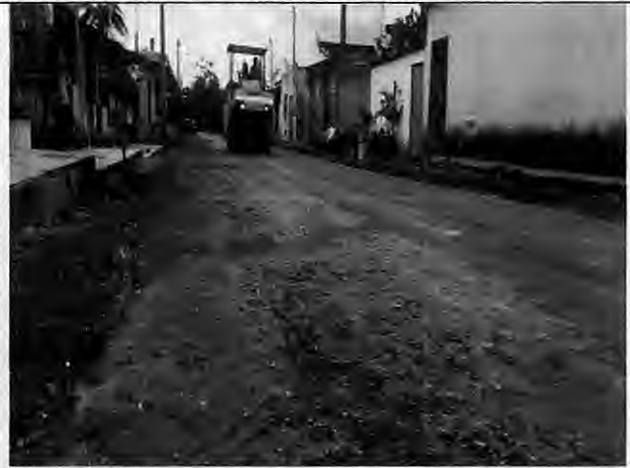
Execução de base Rua Jeruzalém – Antônio Batista
