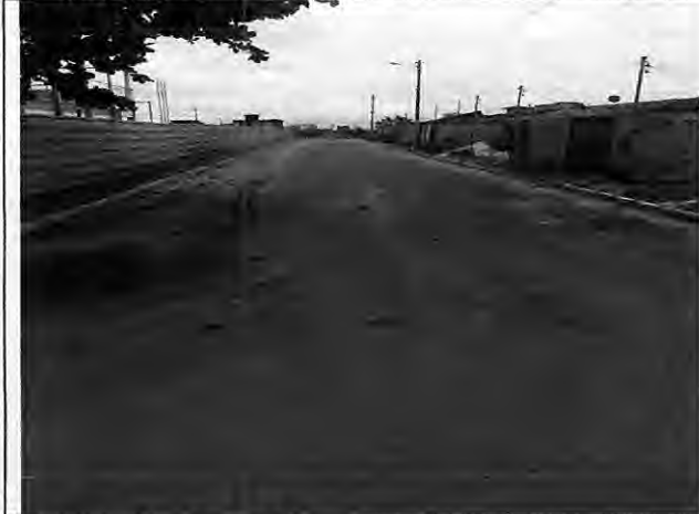
Execução de meio fio Rua das Missões - Antônio Batista
