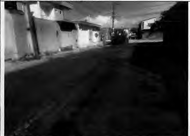
Imprimação de base Rua I - Antônio Batista
