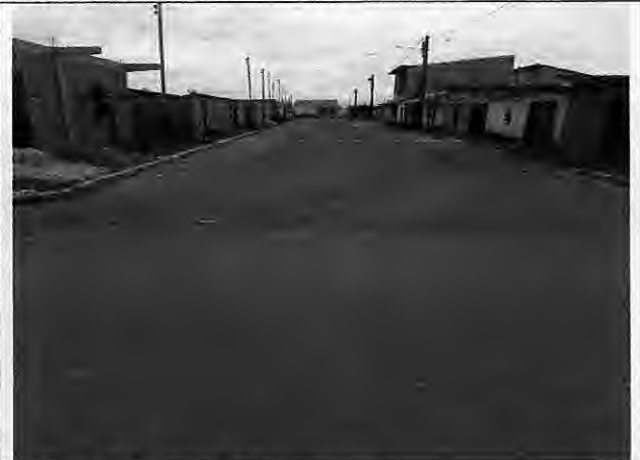
Execução de meio fio Rua Somobra da Tarde - Antônio Batista
