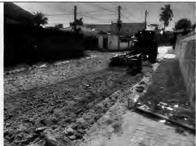
Execução de base Rua C - Antônio Batista
