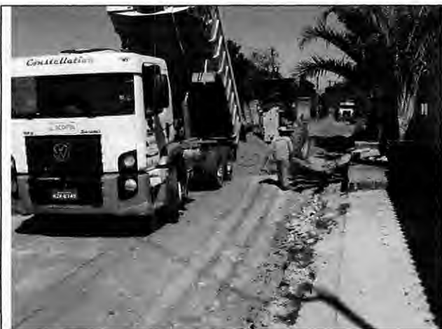
Lançamento de material de base Rua I - Antônio Batista
