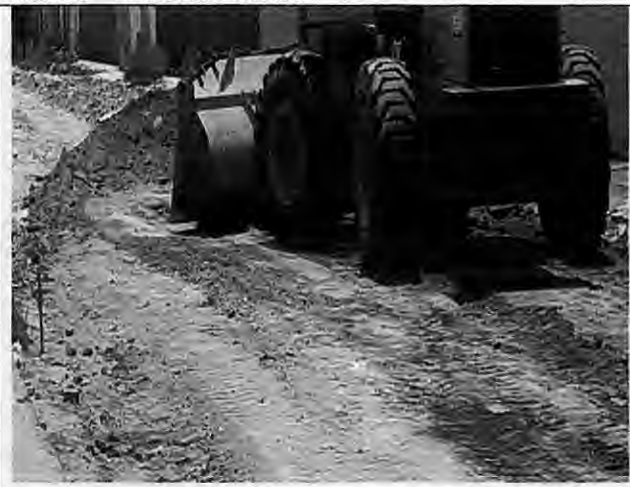
Regularização de Subleito Rua H - Antônio Batista
