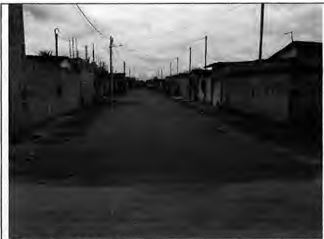
Execução de base Rua F - Antônio Batista
