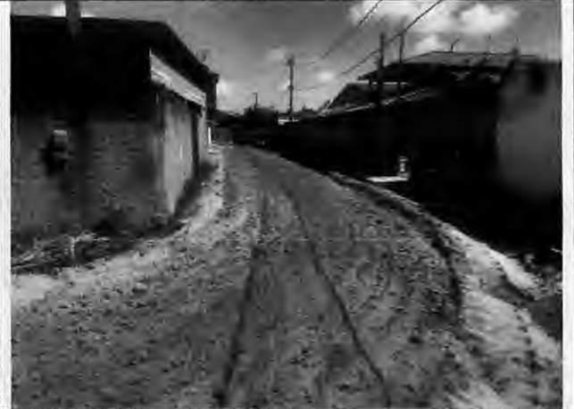
Lançamento de material de base Rua C - Antônio Batista
