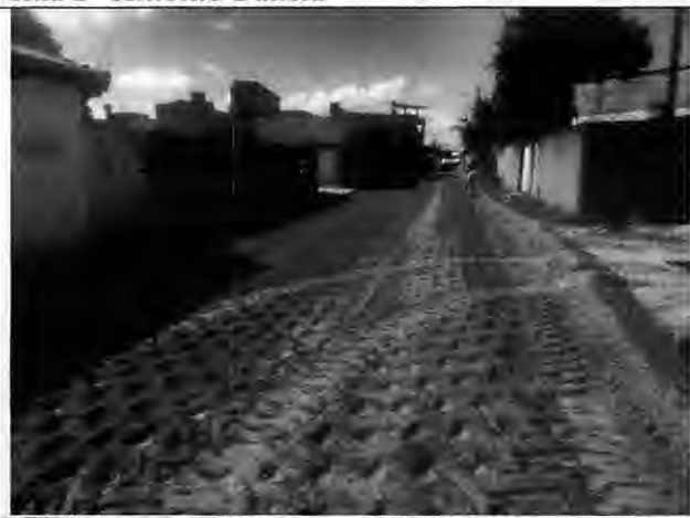
Execução de base Rua I - Antônio Batista
