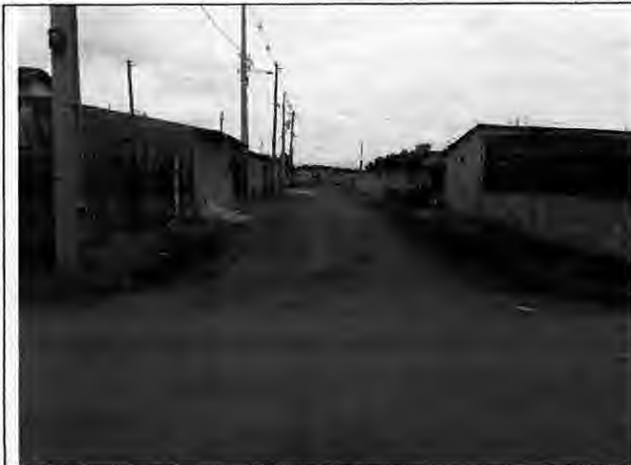
Asfaltamento Rua I - Antônio Batista
