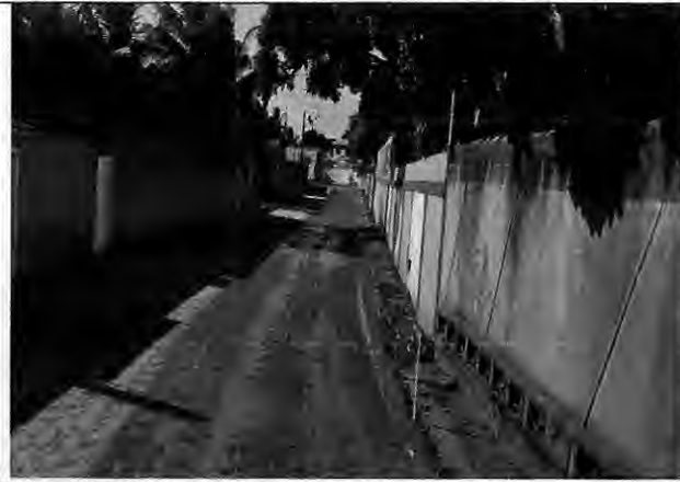
Imprimação de base Rua E - Antônio Batista
