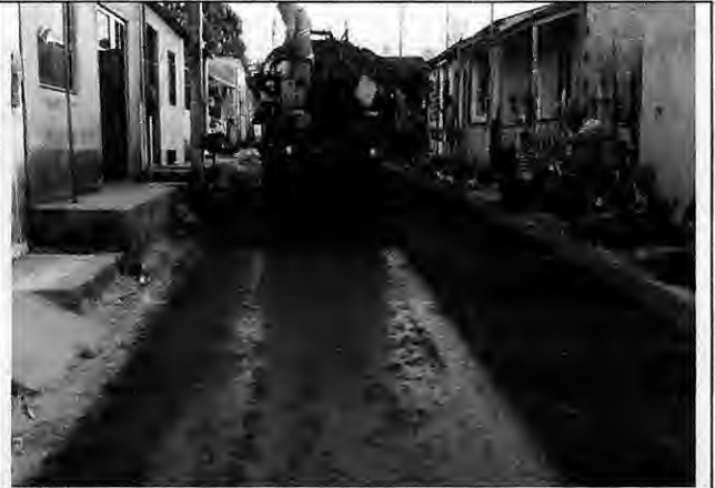
Imprimação de base Rua Sombra da Tarde – Antônio Batista
