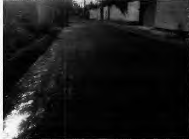
Execução de base Rua G - Antônio Batista
