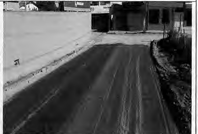
Imprimação de base Rua E - Antônio Batista
