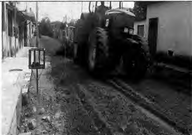
Execução de base Rua das Missões – Antônio Batista
