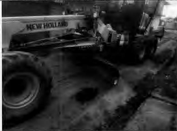
Regularização de Subleito Rua C - Antônio Batista
