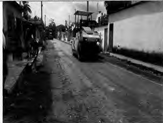
Execução de base Rua Jeruzalém – Antônio Batista
