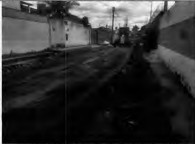
Abertura de caixa de rua Rua A – Antônio Batista
