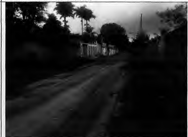
Regularização de Subleito Rua E - Antônio Batista
