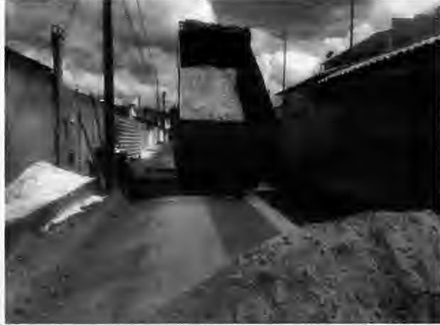
Lançamento de material de base Rua A – Antônio Batista
