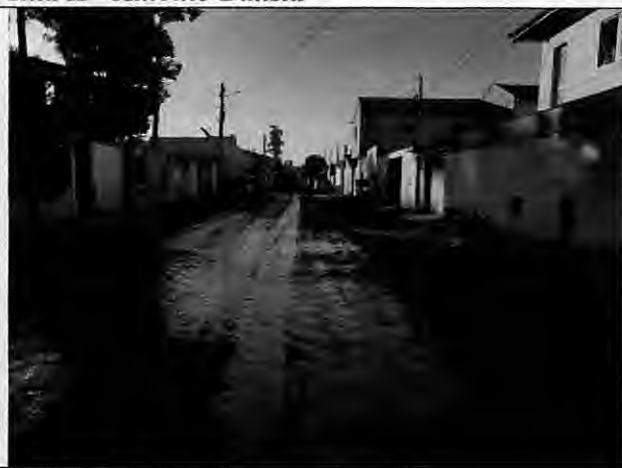
Imprimação de base Rua H - Antônio Batista
