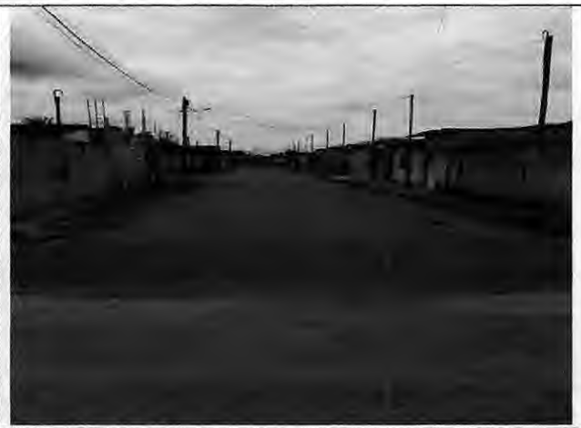
Execução de base Rua F - Antônio Batista
