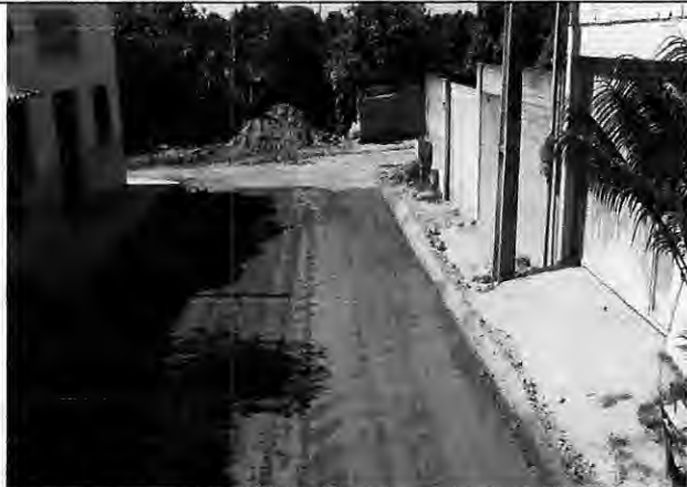
Imprimação de base Rua Sombra da Tarde – Antônio Batista
