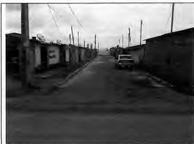
Asfaltamento Rua Israel – Antônio Batista
