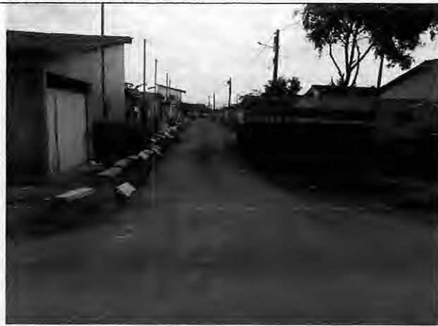
Asfaltamento Rua E - Antônio Batista
