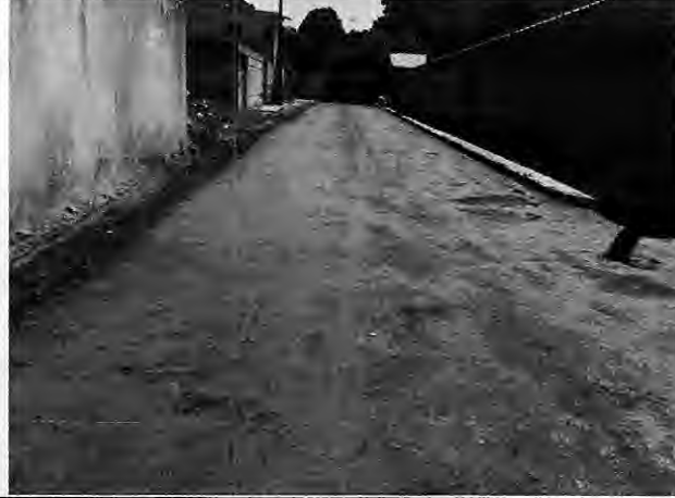
Imprimação de base Rua C - Antônio Batista
