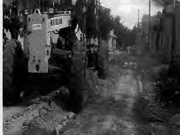
Regularização de Subleito Rua Jeruzalém – Antônio Batista
