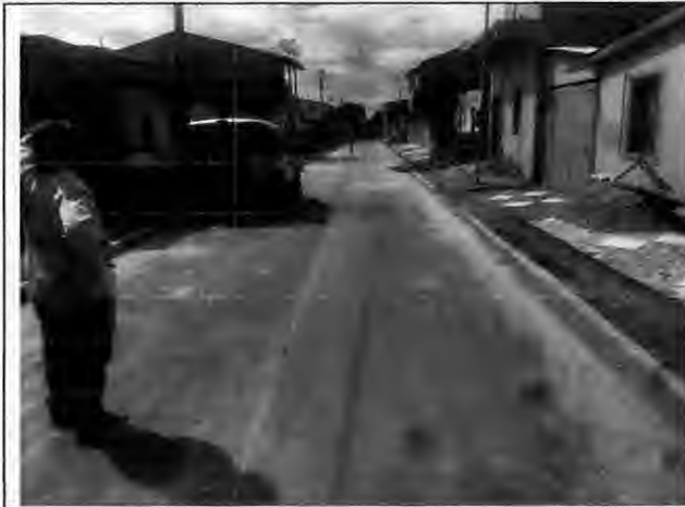
Execução de meio fio Rua C - Antônio Batista
