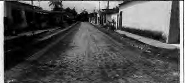
Regularização de subleito Rua Projetada 03 - Pequi
