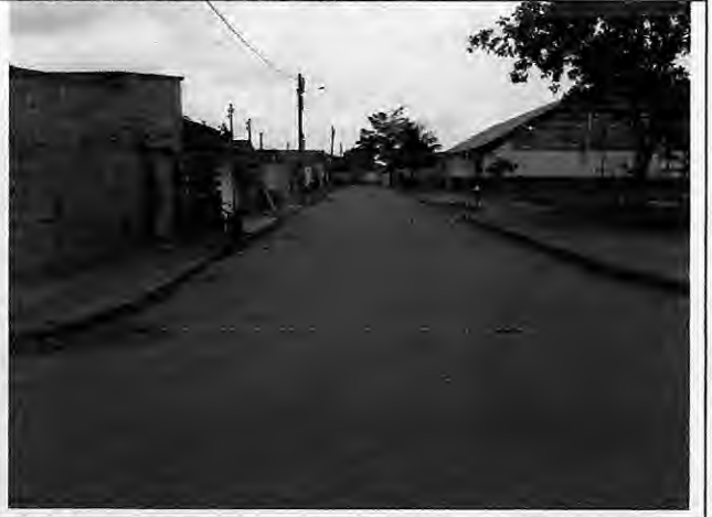
Asfaltamento Rua A – Antônio Batista
