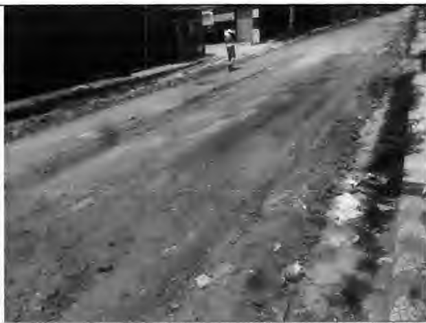
Regularização de Subleito Rua A – Antônio Batista
