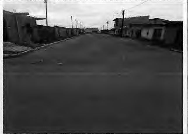
Asfaltamento Rua Sombra da Tarde – Antônio Batista
