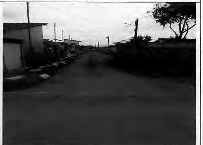
Asfaltamento Rua E - Antônio Batista
