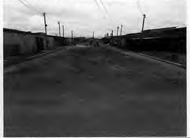
Execução de meio fio Rua Jerusalém - Antônio Batista
