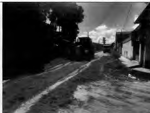
Lançamento de material de base Rua H - Antônio Batista
