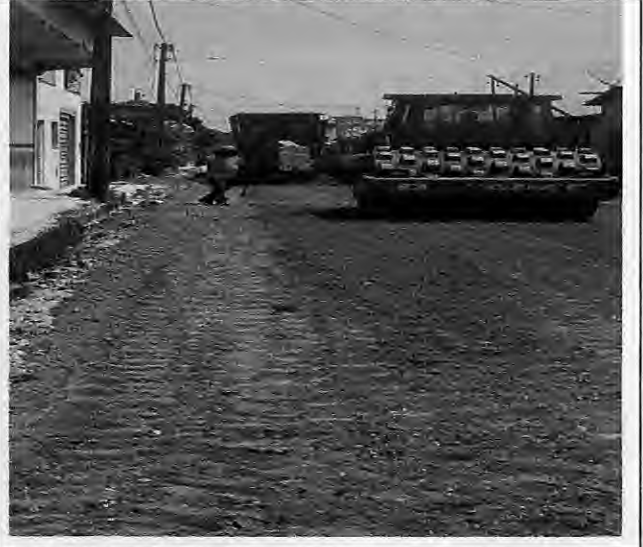
Execução de base Rua Sombra da Tarde – Antônio Batista
