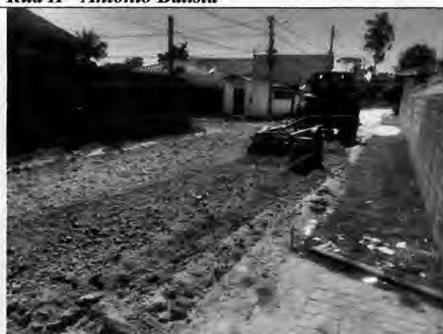
Execução de base Rua H - Antônio Batista
