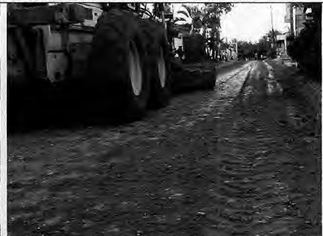
Regularização de Subleito Rua Sombra da Tarde – Antônio Batista
