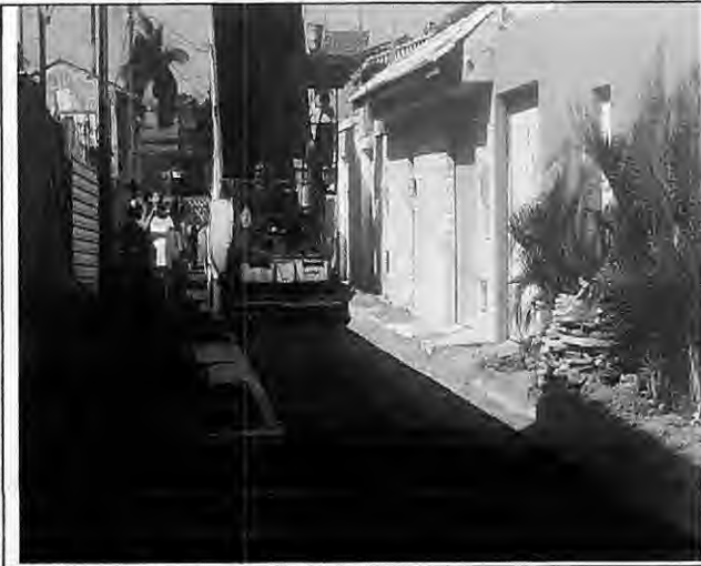
Asfalamento Rua Projetada 03 - Pequi
