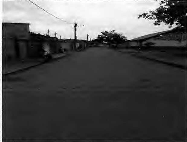
Asfaltamento Rua A – Antônio Batista
