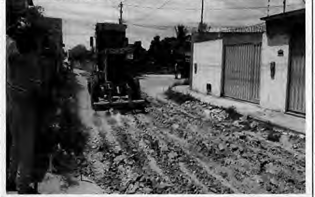
Abertura de caixa de rua Rua Projetada 03 - Pequi
