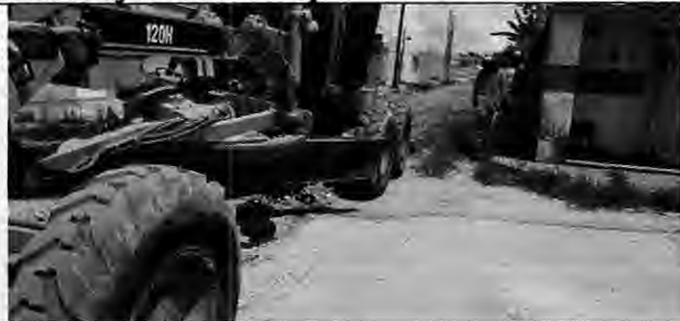
Regularização de subleito Rua Projetada 03 - Pequi
