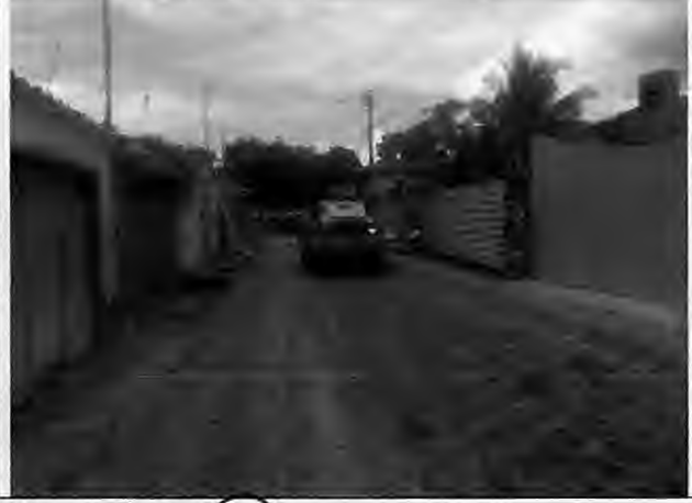
Execução de base Rua A – Antônio Batista
