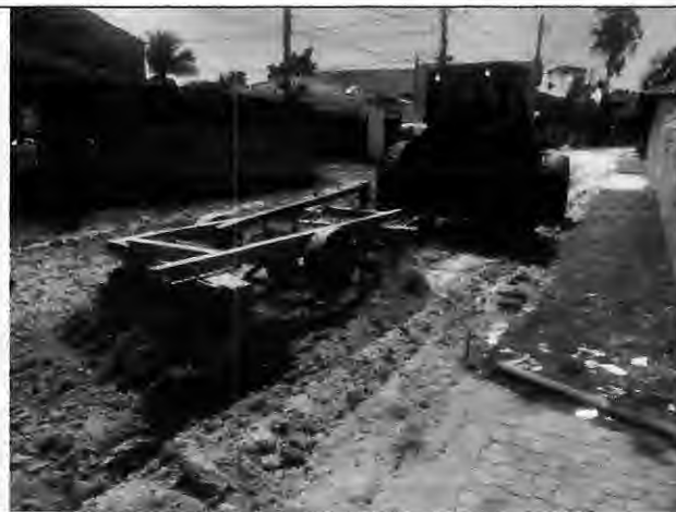
Execução de base Rua C - Antônio Batista
